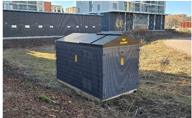
Kuva 3.2. Puistomuuntamo. Muuntamon seinissä on metalliverkko sotkemisen hillitsemiseksi.
