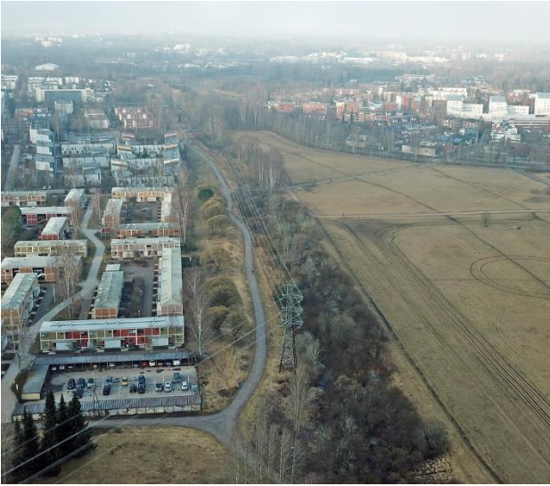
Kuva 3.4. 110 kV voimajohto kaupungissa.
