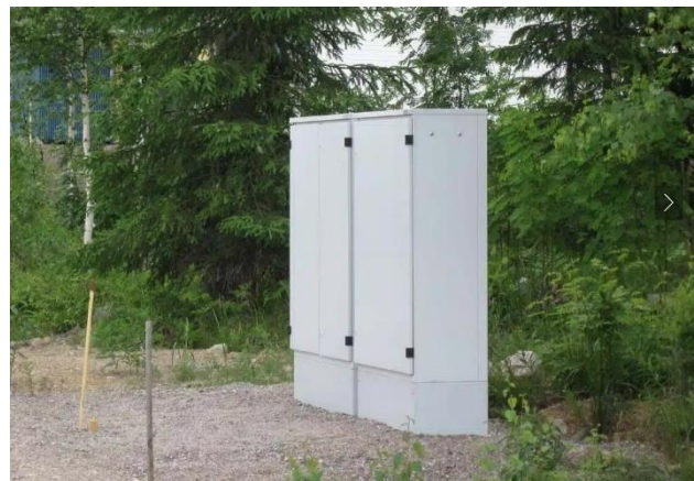
Kuva 3.3. Jakokaappi (kuva: UTU).
