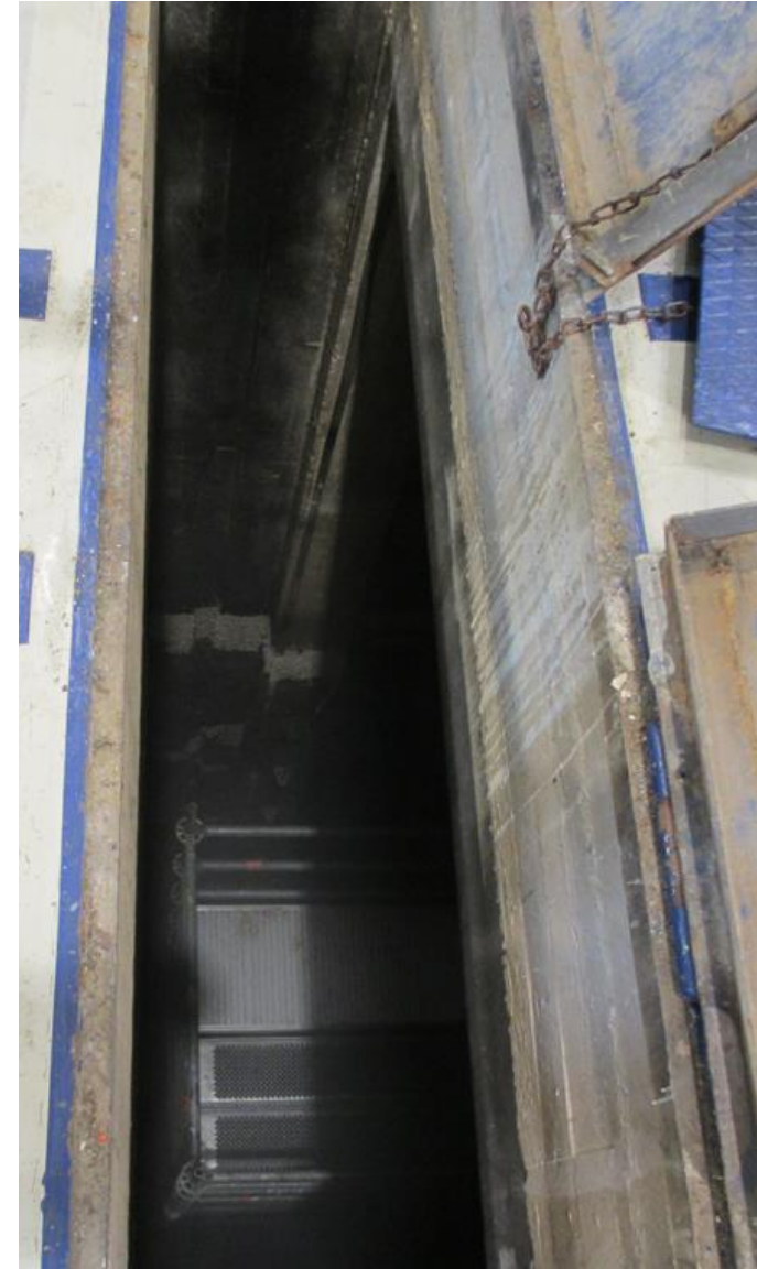
Loviisan voimalaitos, LO1, merivesikammio, merirokkoraita seinällä
