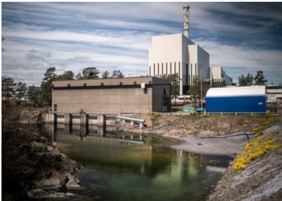
Kuva 5-9. Oskarshamnin laitoksen O3 jäähdytysveden ottoallas ja ottorakennus /Dagens Nyheter 2019/.
