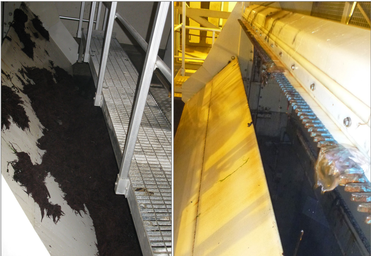
Kuva 6-11. Luulevää Oskarshamnin laitoksen hienovälpällä valumassa lattiakouruun (vasen kuva) ja meduusoita hienovälpän haravassa (Kuva: Oskarshamns Kraftgrupp AB).
