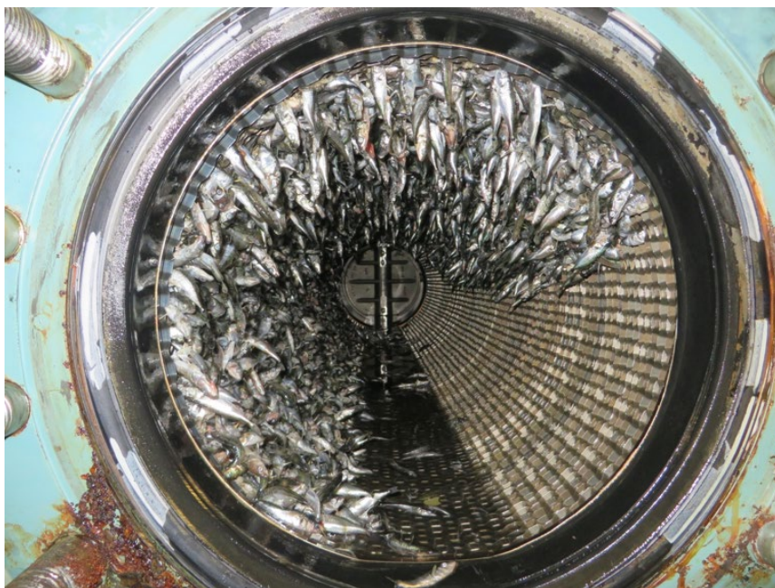
Kuva 6-12. Piikkikaloja kerääntyneenä merivesijärjestelmän seulaan (Kuva: Forsmarks Kraftgrupp AB).
