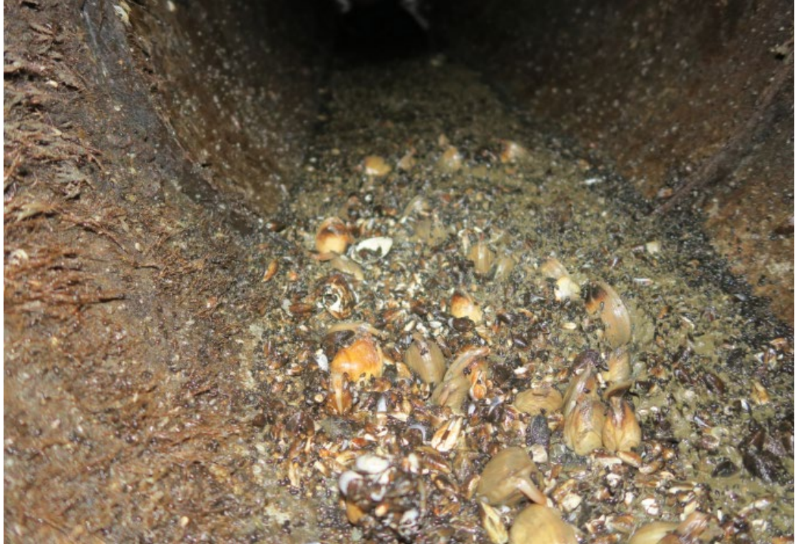
Kuva 6-8. Rangiasimpukkaa ja mahdollisesti muitakin lajeja Loviisan voimalaitoksen merivesijärjestelmän putkessa, jossa vettä ei virtaa jatkuvasti.
