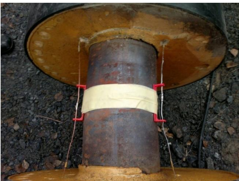
Kuva 2. Tukieristimien kiinnitys virtausputkeen
