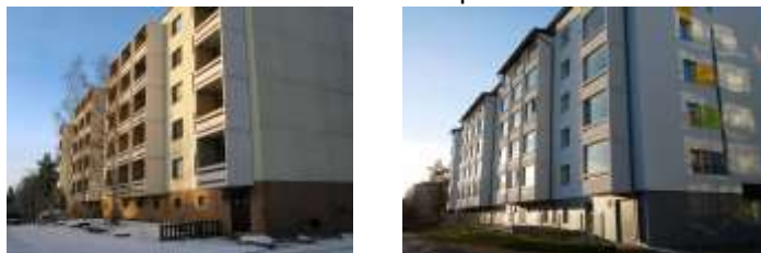
Kuva 2. Esimerkki yhdestä tutkimuksessa mukana olleista rakennuksista ennen remonttia ja sen jälkeen.
