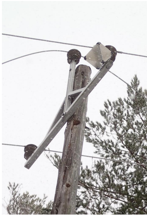
Kuva 19. Tutkaheijastimen asentaminen jännitetyösauvoilla ja lähikuva asennetusta heijastimesta.
