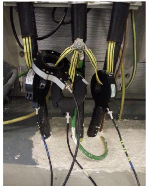
Kuva 3.10. Tutkauspulssin syöttö kaapelin suurtaajuusvirtamuuntajalla kaapelin pituuden tai pulssin kulkuajan määrittämiseksi [Pak15a].
