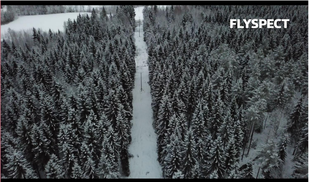
Kuva 11. 20 kV:n linjaa kuvattuna DJI Mavic Pro:n 4K-kameralla (kuvakaappaus videosta)
