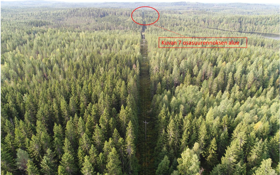
Kuva 6. 20 kV:n ilmajohtoa multikopterista kuvattuna
