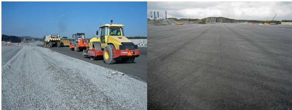
Kuva 5.6 Vasen: kerrosstabilointityöt käynnissä Vuosaaren satamassa. Oikea: Valmis kenttärakenne. Kerrosstabiloinnin tuoman kantavuuslisäyksen avulla voitiin päällysteen paksuutta ohentaa lähes 80 %. (Kuvat: Tero Jokinen, Ramboll)
