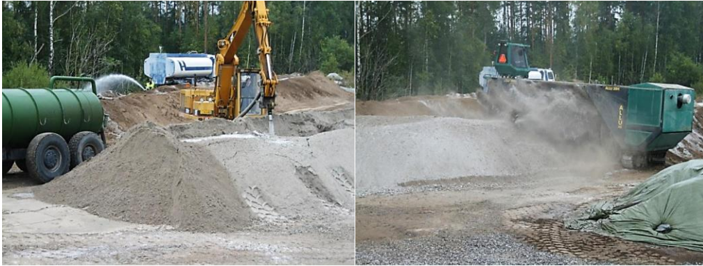
Kuva 8.3 Aumasekoitus - tuhkan ja sementin sekoitus. (Kuvat: Harri Jyrävä, Ramboll)
