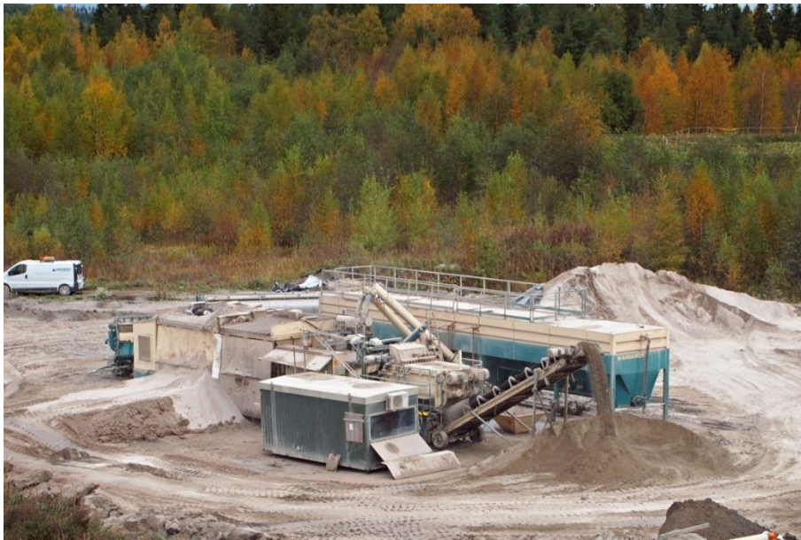
Kuva 12.8 Asemasekoitin valmistamassa lentotuhkapohjaista sideaineseosta kerrostabilointikäyttöön. (Kuva: Olli Kiviniemi, Ramboll)
