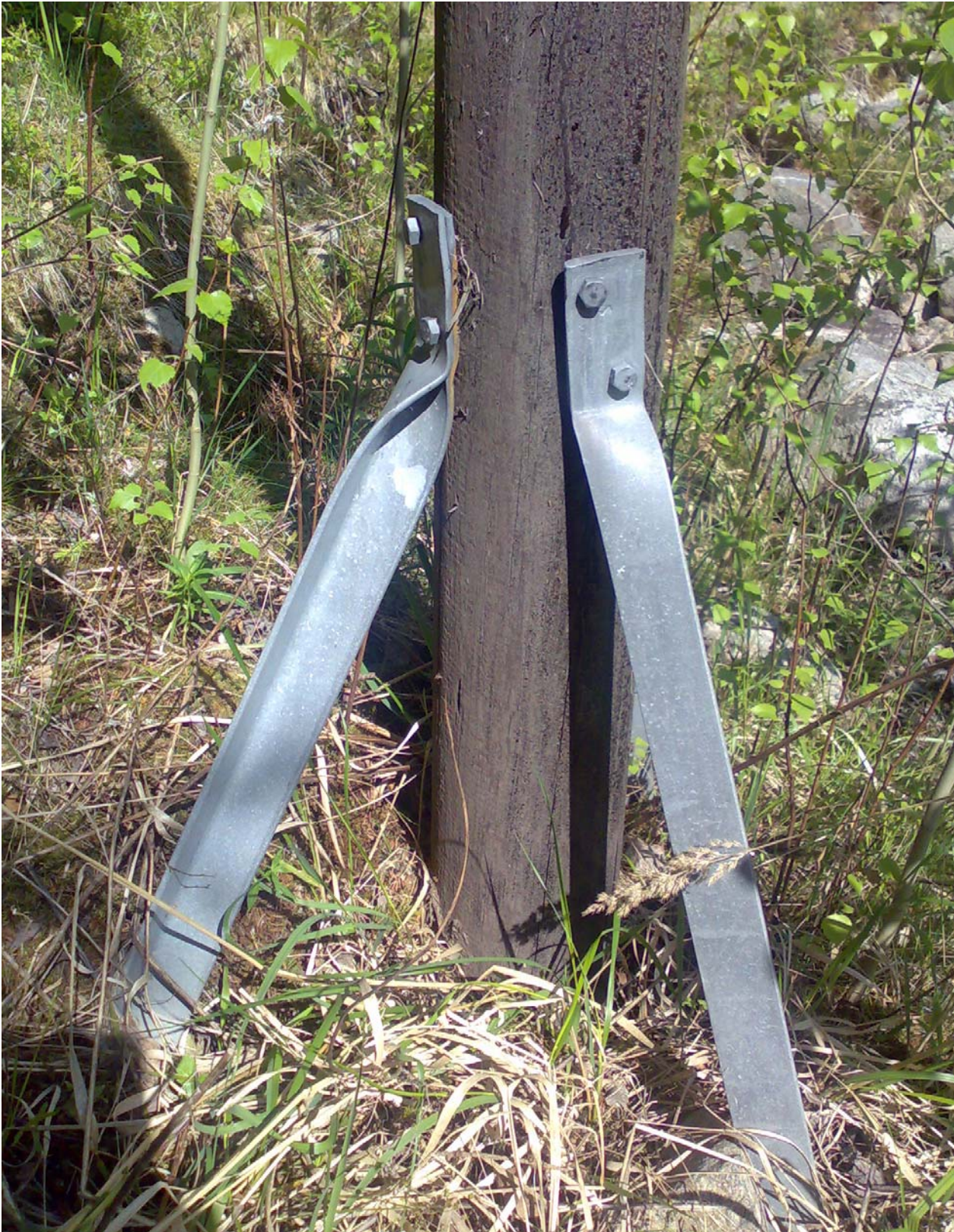
Kuva 24. Kahdeksan vuotta vanhan tyvituetun mäntyöljykyllästetyn puupylvään tyviosa, jossa öljypitoisuus noin 100 kg/m 3 .
