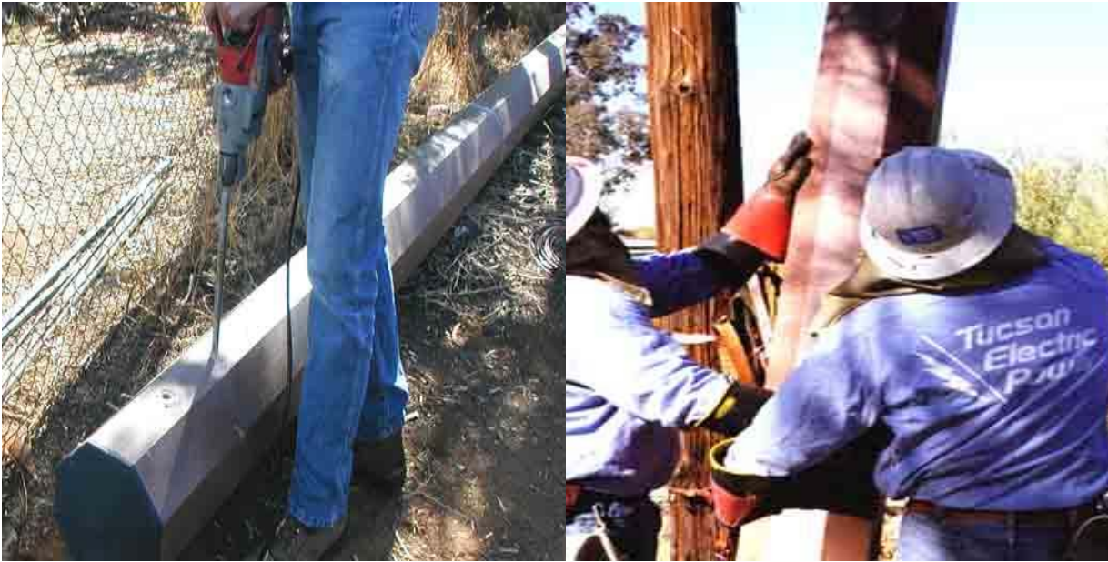
Kuva 48. Komposiittipylväiden asennusta Pohjois-Amerikassa.
