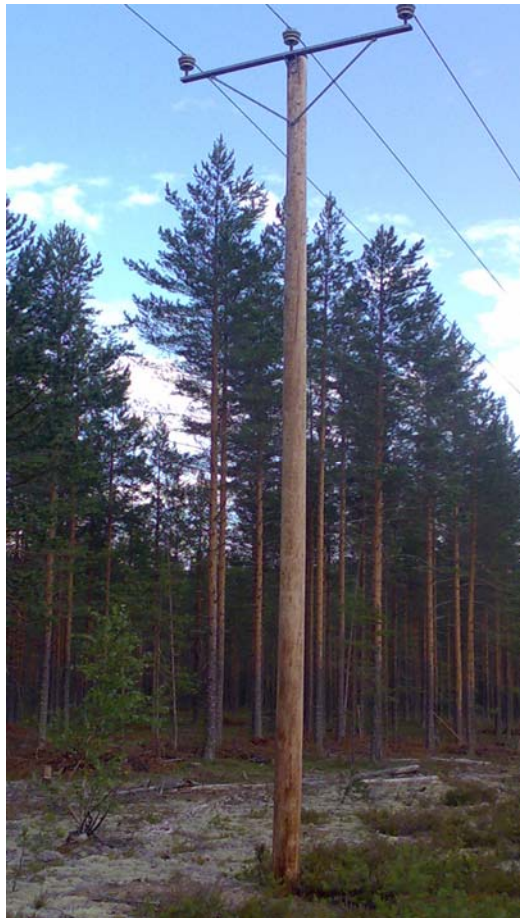
Kuva 54. Lehmon koelinjan kreosoottikyllästetty (80 kg/m 3 ) puupylväs, jossa orsityyppi Headpower G11.
