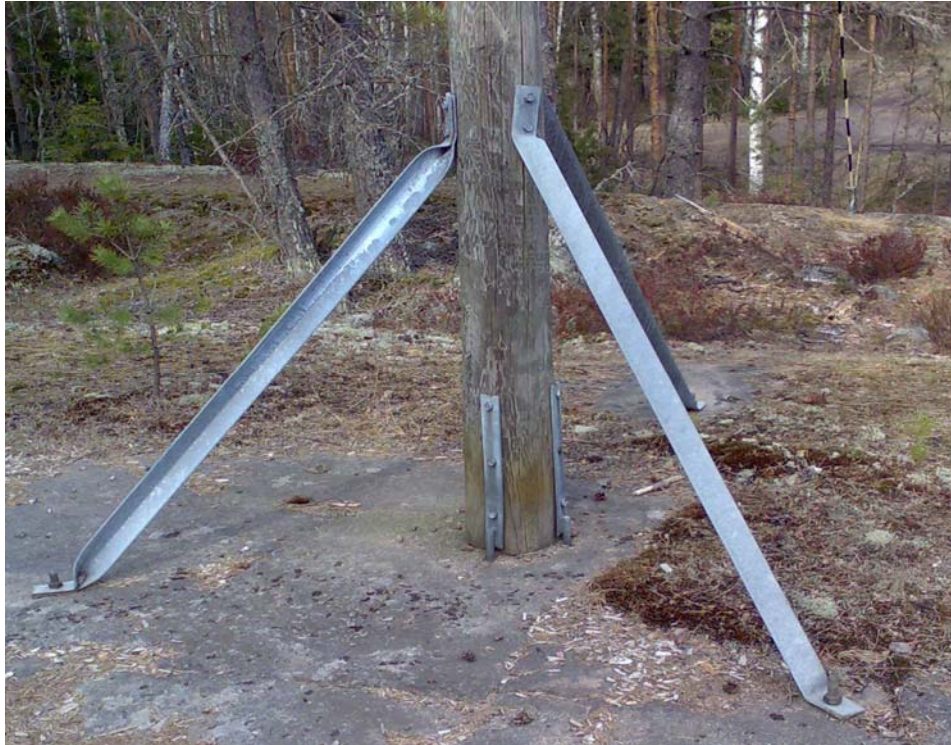
Kuva 55. Kallionpylvään kiinnitystapoja voidaan hyödyntää myös maaperään upotettavilla pylväillä.
