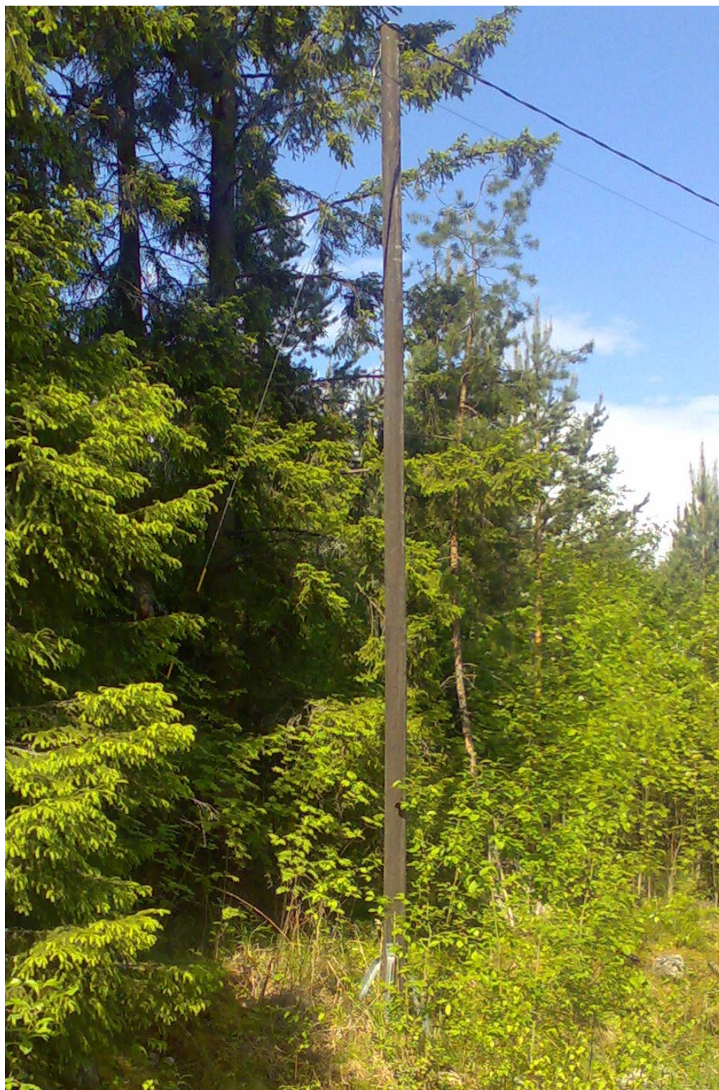
Kuva 25. Kahdeksan vuotta vanhan tyvitetun mäntyöljykyllästetyn puupylväs, jossa öljypitoisuus noin 100 kg/m 3 .
