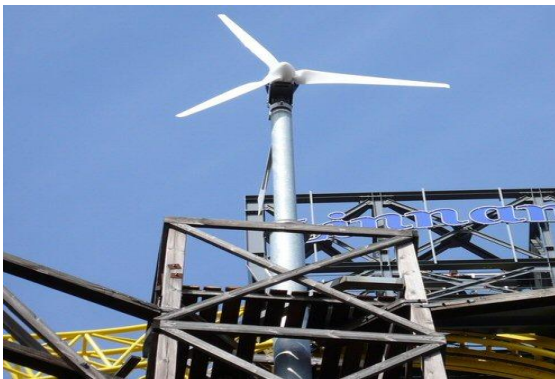
Kuva 2. Kolmen ja puolen kilowatin pientuulivoimala Linnanmäellä (28.4.2011 - Uutiset 2011).
