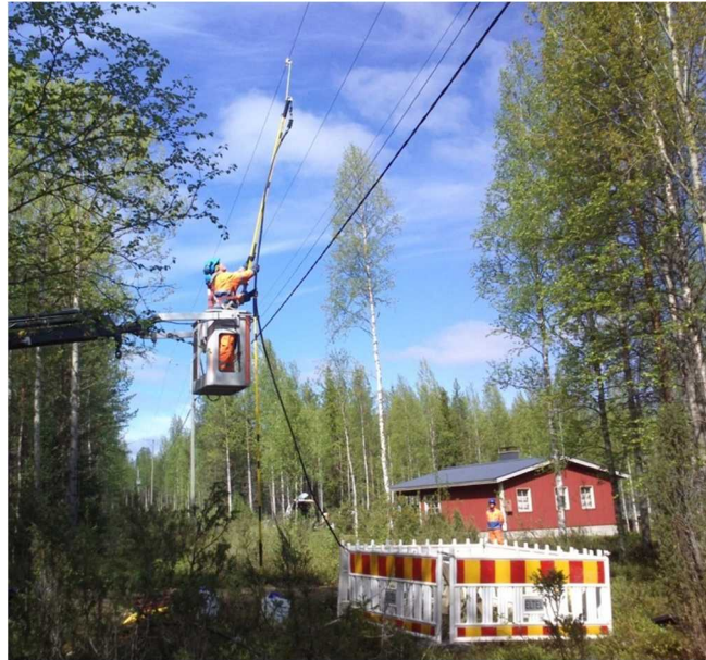
Kuva 6. Maasulku jännitetyönä: vesivastus aidattuna edessä oikealla.
