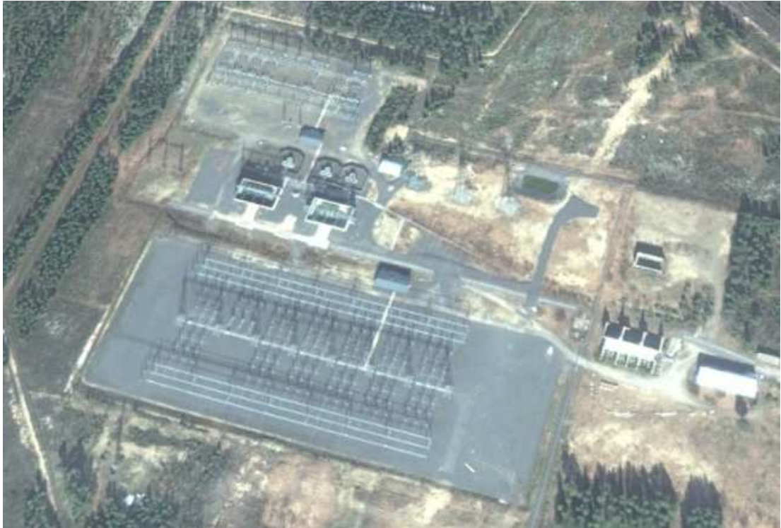
Kuva 4. Pikkaralan sähköasema Googlen satelliittikuvassa (Lähde: GoogleEarth), /11/
