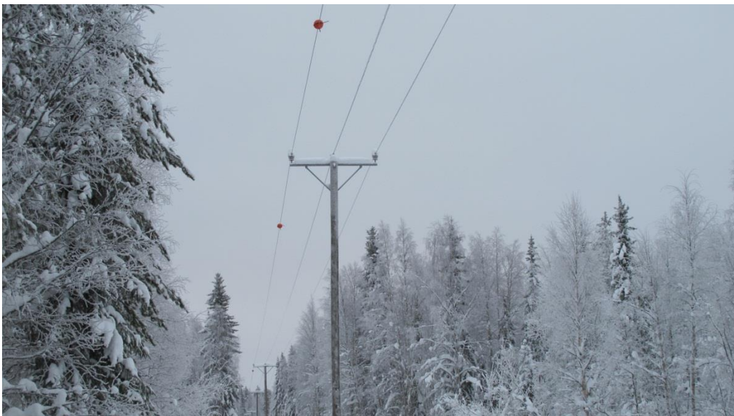
Kuva 20. Mittausyksiköt voimalinjalla
