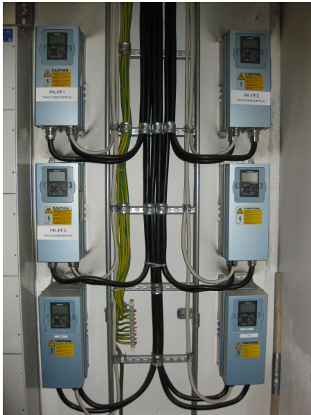
Kuva 6.19. a) Häiriöitä aiheuttaneet Vacon NXL taajuusmuuttajat b) taajuusmuuttajan tyypikilpi.
