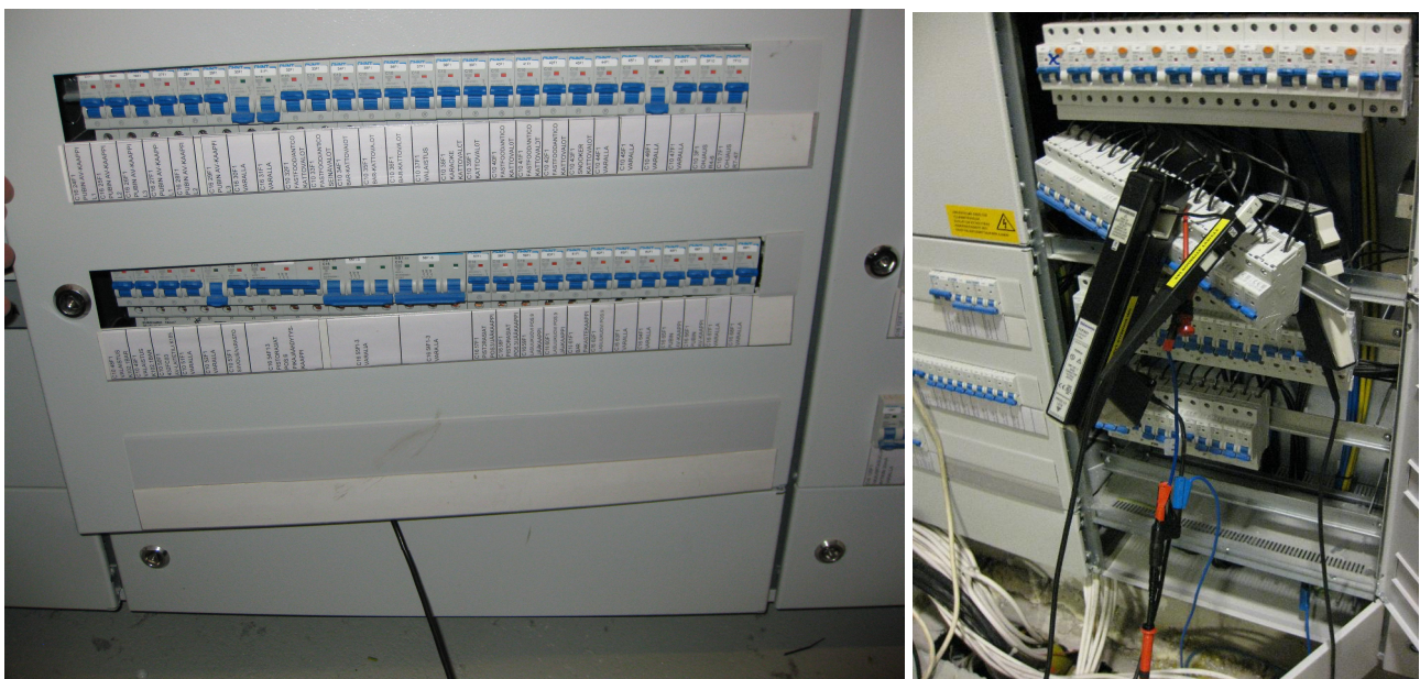
Kuva 3.25. Johdonsuojakytinrivit, joilta mittaukset tehtiin a) pubia ja b) ravintolaa syöttävillä ryhmäkeskuksilla.
