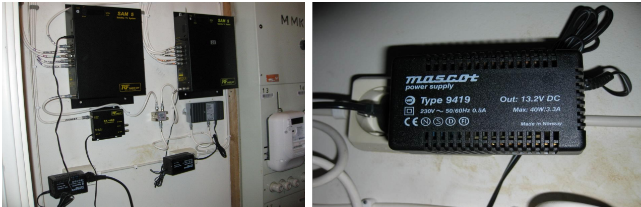
Kuva 6.5. Satelliittikeskusantennijärjestelmän vastaanottimet ja tehollähteet.
