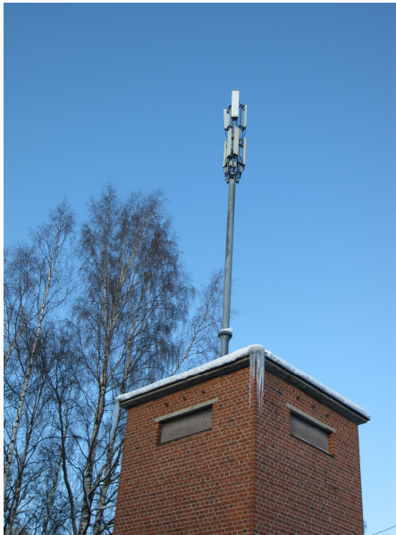
Kuva 6.15. a) Häiriötä aiheuttaneen matkapuhelintukiaseman antennit muuntamokopin katolla, b) matkapuhelintukiaseman teholähteen häiriöjännitteiden taajuusspektrit.
