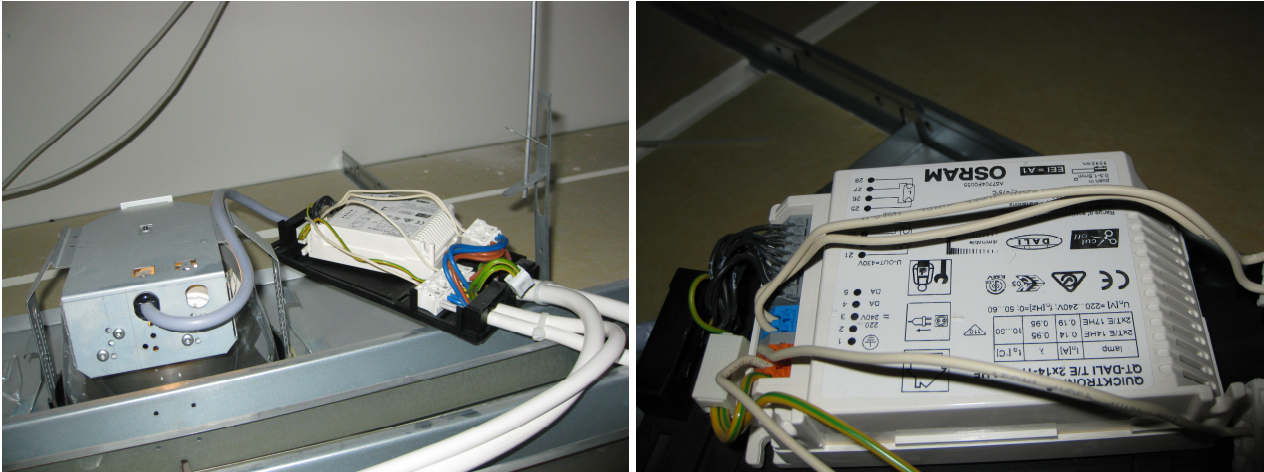
Kuva 3.28. Yksi ravintolan valoryhmän valaisimista ja valaisimen erillinen elektroninen liitäntälaitte. Valaisimessa on kaksi sarjaan kytkettyä pienloisteputkea.
