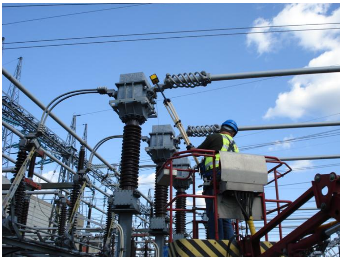
Kuva 5.19 Esimerkki mittauksesta työpisteestä ”virtamuuntajan ensiöliittimien tarkastus nostokorista” 110 kV sähköasemalla (sähkökenttä 3,0 kV/m).
